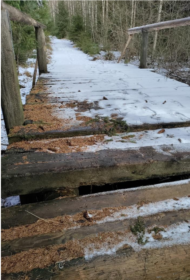
Kuva 5. Sama silta toisesta päästä kuvattuna. Sillassa on porras, joka on hevosille hankala.
